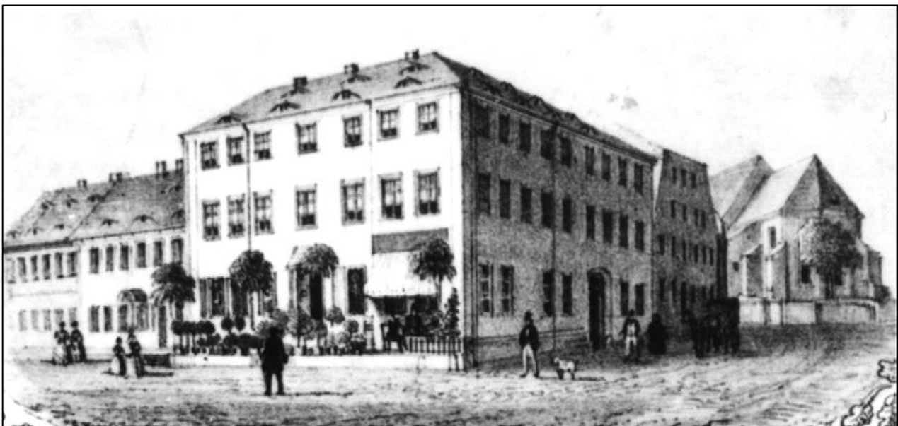
Das 2. Knoblochsche Haus („Stammhaus“) 1853. Rechts anschließend das Haus Kirchstr. 1 im ursprünglichen Zustand. Der heutige Kirchturm wurde erst 1887/1888 gebaut.
