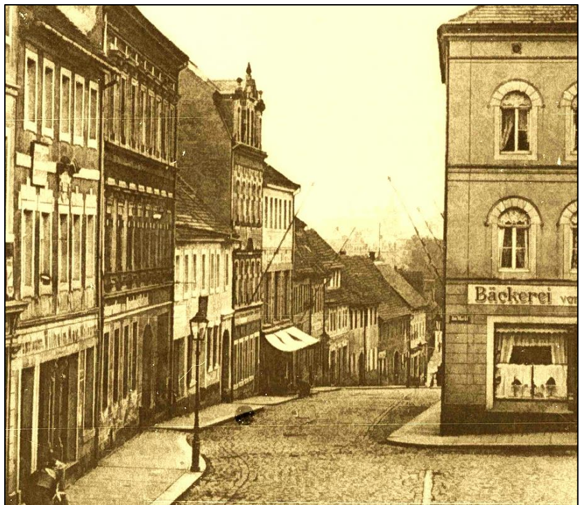
Das erste „Knoblochsche Haus“ (Cat.-Nr. 55) in Radeberg, „Pirnaische Gasse“, links mit den Markisen. Auf dem Foto von ca. 1900 ist es bereits um 1 Etage aufgestockt.
