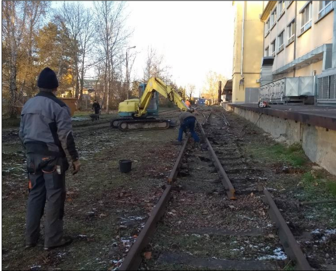
Gleisabbau hinter dem Wareneingangsgebäude. Foto: Jörg Gottschlich
