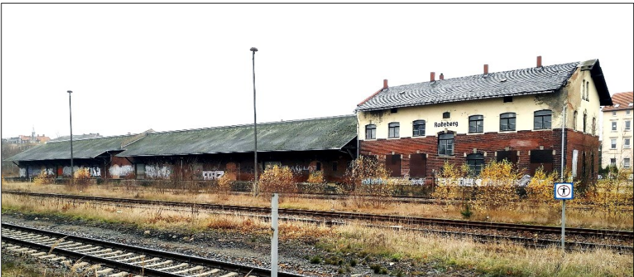
Das „Güterabfertigungsgebäude“ mit seinem Verwaltungsanbau. Aufnahme von 2018.
