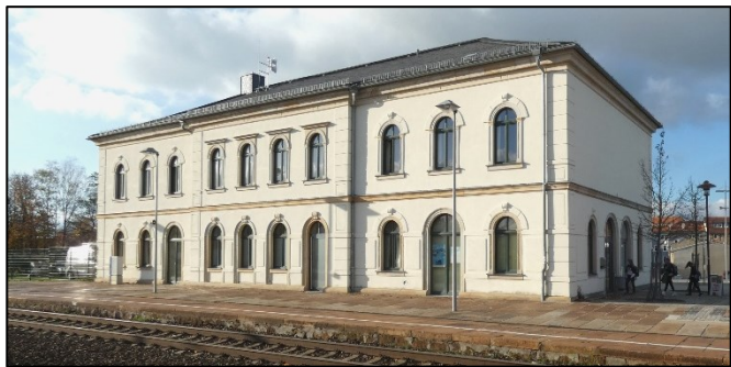
Die Wirklichkeit 2020: Bahnhof Bischofswerda (Gleisseite) – baugleiches Duplikat des Radeberger Bahnhofes von 1845. Der Scheingiebel ist abgetragen worden. Foto: Schönfuß
