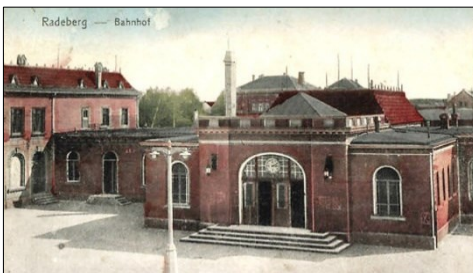
Die 1916 eröffnete große mittige Empfangshalle vergrößerte die bebauter Fläche um ca. 160 qm auf insgesamt ca. 1.190 qm. Aufnahme von 1921
