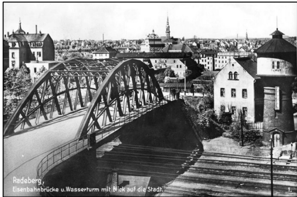
Das zweite „Arbeiter-Wohnhaus“ des Radeberger Bahnhofes, 1874 am damaligen Ost-Rand des Bahngeländes errichtet. Im Bild die Giebelseite zwischen Brücke und Wasserturm, die beide später gebaut worden waren. Alte Ansichtskarte
