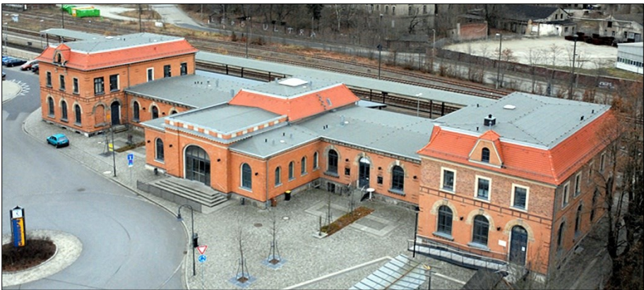
Deutlich sind Symmetrie und Harmonie des heutigen Bahnhofsgebäudes zu erkennen. Quelle: Lunze-Architekten Radeberg. Mit Dank für die freundliche Veröffentlichungsgenehmigung vom 7. August 2024
