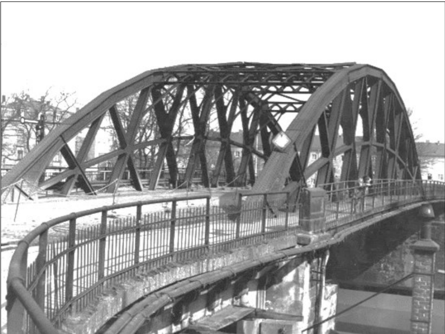
Die Stahl-Bogenbrücke kurz vor der Demontage 1973, aus Richtung Pillnitzer Straße gesehen. Am unteren Bildrand ist deutlich die 1915 angebaute Betonbrücke zu erkennen.
